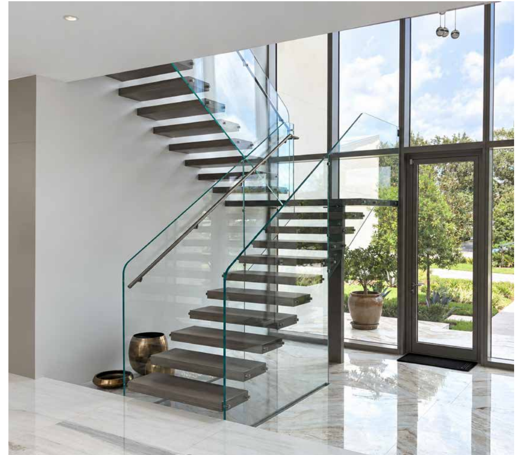
Scala a sbalzo a giorno con gradini in massello di rovere lista intera. Ringhiera modello M6 in vetro strutturale extra-chiaro con corrimano in acciaio inox. ● Open cantilever staircase with steps in solid full-stave oak. Banister model M6 in ultra-clear structural glass with stainless-steel handrail. ● Escalier en encorbellement à jour avec des marches en bois de rouvre massif lame entière. Garde-corps modèle M6 en verre structuré extra-clair avec main courante en acier inoxydable. ● Offene freitragende Treppe mit Stufen aus massivem, durchgehendem Eichenholz. Geländer Modell M6 aus extra klarem Strukturglas mit Handlauf aus Edelstahl. ● Escalera en voladizo abierta con peldaños de roble macizo de tabla entera. Barandilla modelo M6 de vidrio estructural extraclaro con pasamanos de acero inoxidable.
