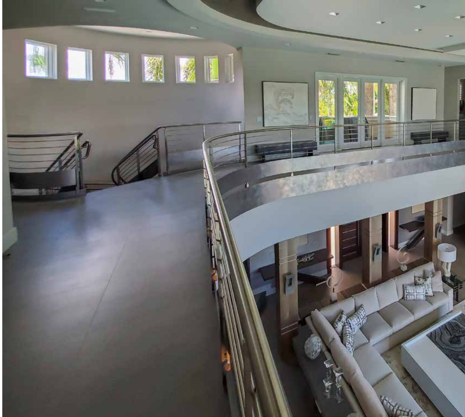
Scala con strutture in acciaio inox elicoidali e gradini rivestiti in resina. Ringhiera curva elicoidale modello M20 a tondini orizzontali e lamiera in acciaio inox. ● Staircase with helical structures in stainless steel and resin-coated steps. Curved helical banister model M20 with horizontal bars and stainless-steel plate. ● Escalier avec des structures en acier inoxydable hélicoïdales et des marches revêtues de résine. Garde-corps courbé hélicoïdal modèle M20 à lisses horizontales et tôle en acier inoxydable. ● Wendeltreppe mit Edelstahlkonstruktion und Stufen mit Harzbeschichtung. Gewundenes Wendeltreppengeländer Modell M20 mit horizontalen Rundstäben und Edelstahlblech. ● Escalera con estructuras helicoidales de acero inoxidable y peldaños revestidos de resina. Barandilla curva helicoidal modelo M20 con varillas horizontales y chapa de acero inoxidable.
